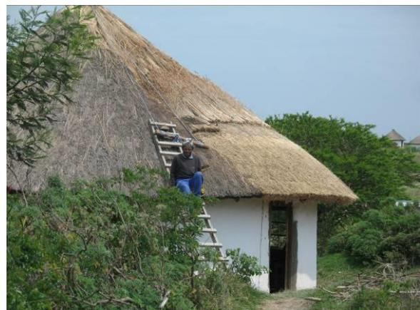
*Binden des Grases für das neue Rietdach, das wir zuerst geschnitten und getrocknet hatten*
